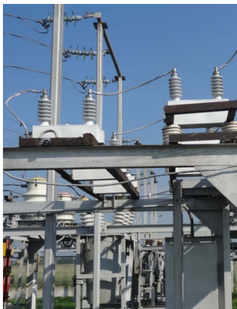
Рисунок 4.15 – Установка конденсаторов на подстанции при испытаниях
