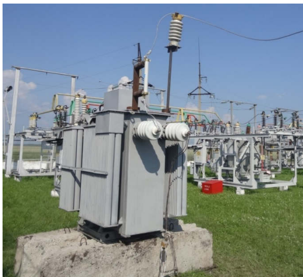
Рисунок 4.10 – Установка ДГР на подстанции
