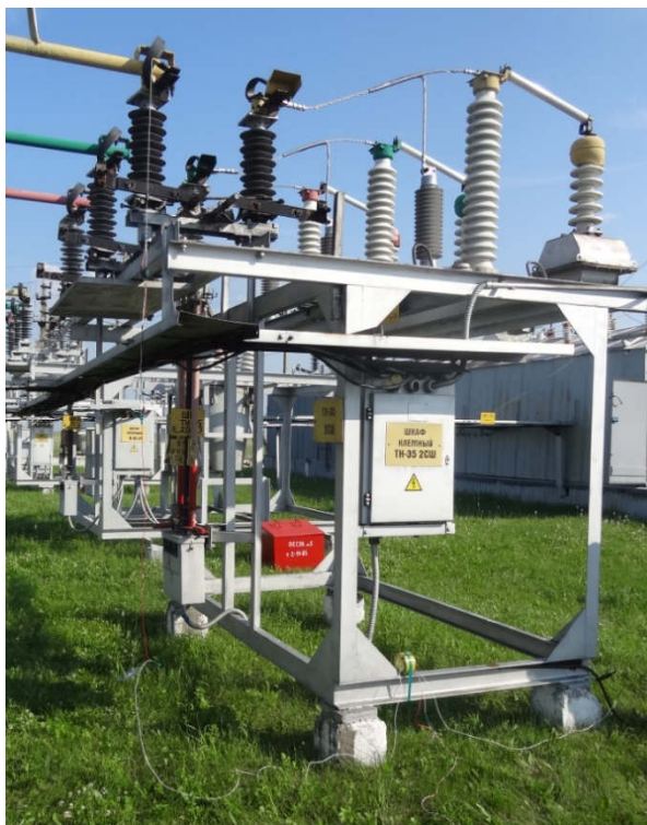
Рисунок 4.18 – Подключение индуктора
