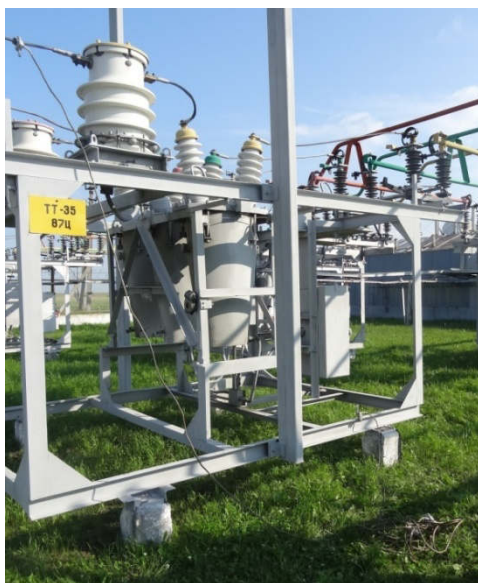
Рисунок 4.11 – Установка и подключение переносного заземления
