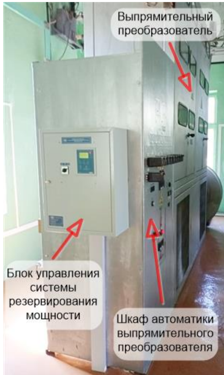
Рисунок 4.5 – Внешний вид блока управления системы резервирования мощности, смонтированного на одной из тяговых подстанций
